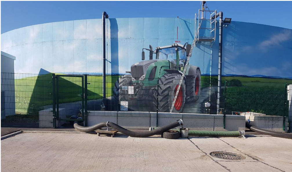
[Detail Abfüllplatz mit Spritzschutzwand und Anfahrerschutz]
