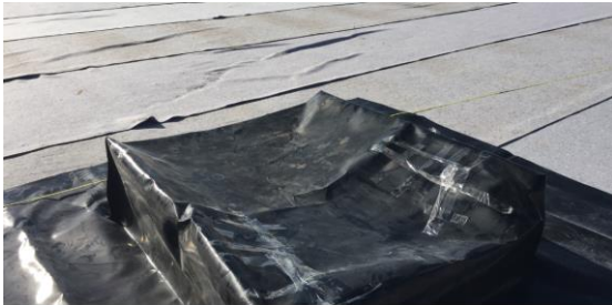
[Detail Element Pumpensumpf vor Ort angeschweißt]
