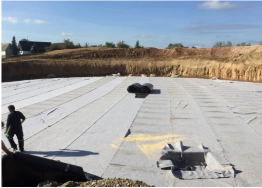
[Schutzvlies vor Verlegung der Folie]
