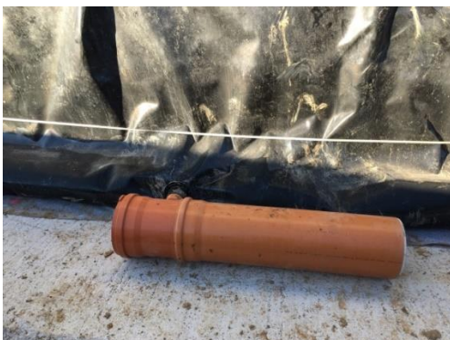
[Detail Anbindung Kontrollschacht an Folie]
