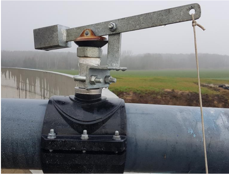
[Detail Hebersicherung von unten bedienbar]
