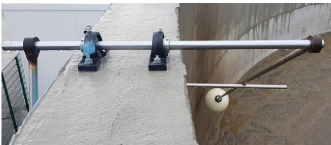
[Detail mechanische Überfüllsicherung mit Anzeige]
