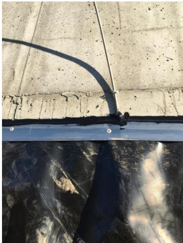
[Detail dicht angebrachte Folie]
